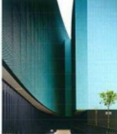
→ **Façade ventilée** pour un immeuble de 875 logements sis au cœur de la ville de Västerås (Suède). 320 et 400 x 650 cm en grès cérame isolé et isolé isolé enroulé sur mesure selon les désirs de l'architecte.
